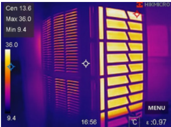
Inspeção de AVAC
