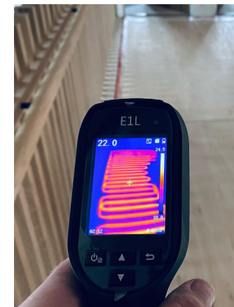
Inspeção de AVAC
