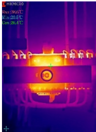
Inspeção de componentes elétricos
