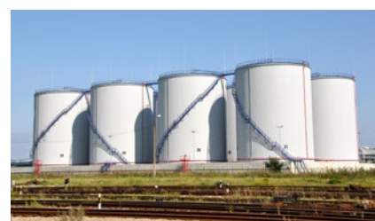
DEPÓSITOS DE COMBUSTIBLE
